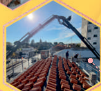
Rifacimento manto di copertura
