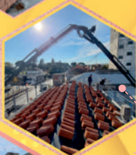
Rifacimento manto di copertura
