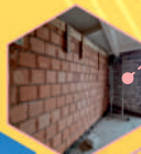
Realizzazione di parete interne in muratura
