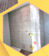
Posa pavimenti e rivestimenti bagni esecuzione di finiture interne
